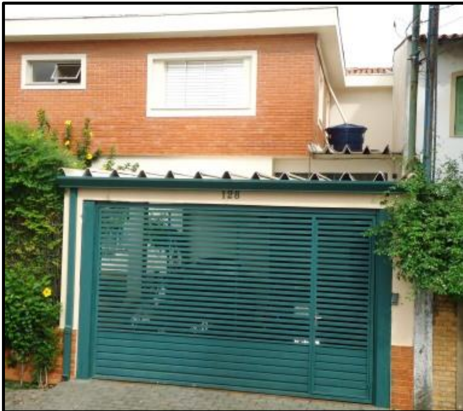
Dispositivo para acumulação e uso de águas de chuva através de recolhimento das águas pluviais incidentes sobre o telhado
